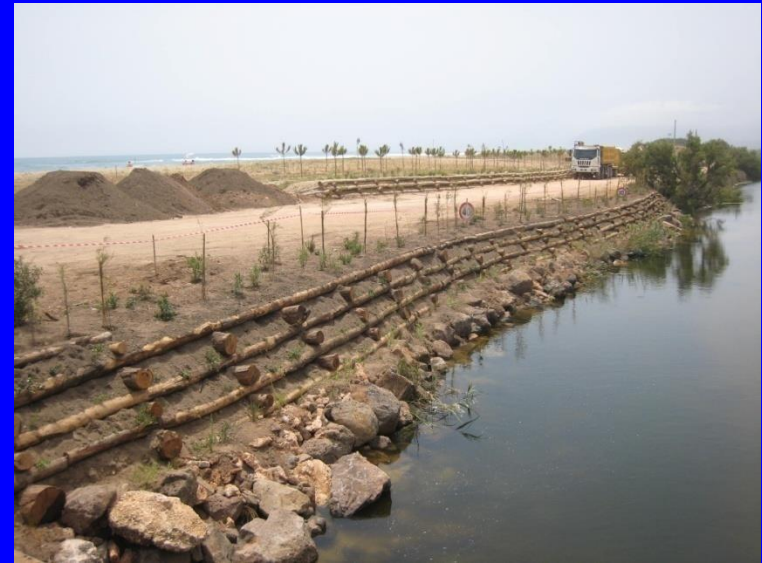
maggio 2008 fine lavori
