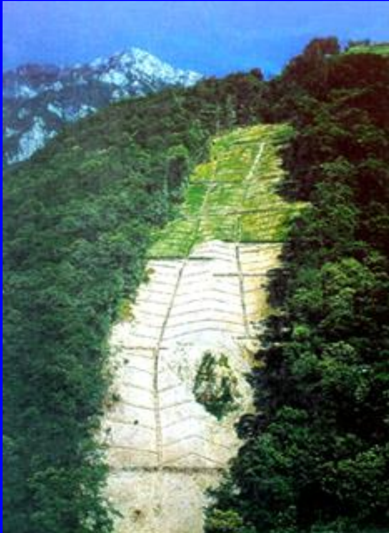
Maggio 1999 (fine lavori)
