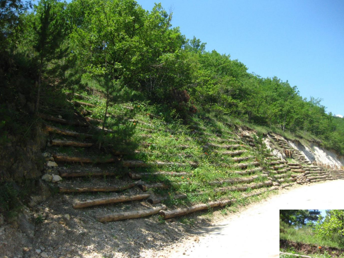
Grate su scarpate in roccia calcarea Abruzzo luglio 2011 Foto Cornelini
